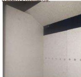
6. Colocar el ladrillo del lado izquierdo. Asegúrate de que el tabique interior se coloque en su posición correcta en la parte superior de los ladrillos laterales
