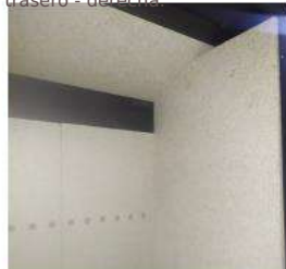
5. Coloque el ladrillo del lado derecho
