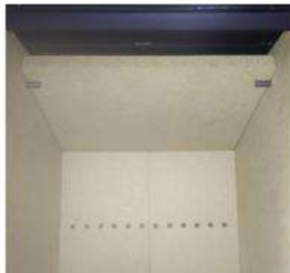
7. Para ajustar el divisor, colocar el divisor en posición sobre barra de soporte del divisor (izquierda y derecha).
