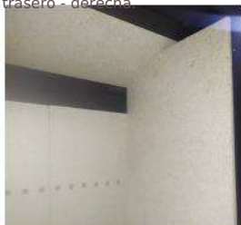
5. Colocar el ladrillo del lado derecho
