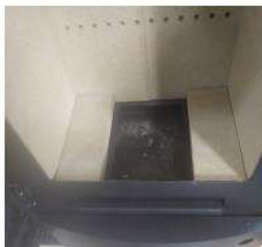
9. Colocar el ladrillo inferior - izquierda.
